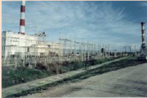
Σταθμός Σορωνής, ΡΟΔΟΣ
